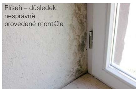
Plíseň na PU pění po osmi měsících
